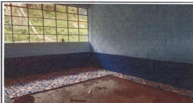
Foto 6: Sustrucción de piso cerámico
