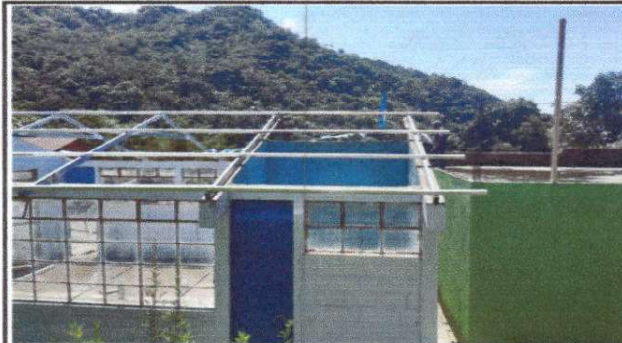
Foto 2: Sustrucción de capote de lámina para lámina troquelada aluzinc calibre 26
