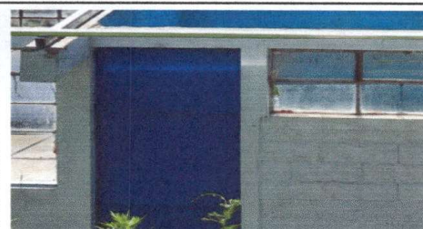
Foto 5: Mantenimiento a estructura de puerta (lijado, pintado)
